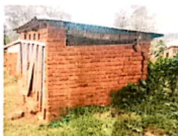
Alte Toiletten, die bisher von den Schülern genutzt wurden
