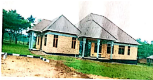
Sammeln von Regenwasser vom Verwaltungsgebäude zu den Wassertanks
