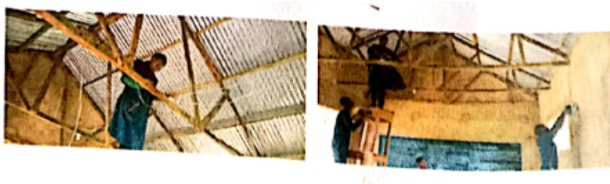
Elektriker-Schüler bei ihren Arbeiten
